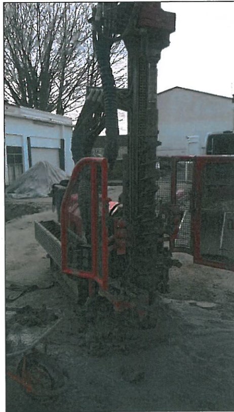
Figure 7 : Mise en place de l'ouvrage PZ1
